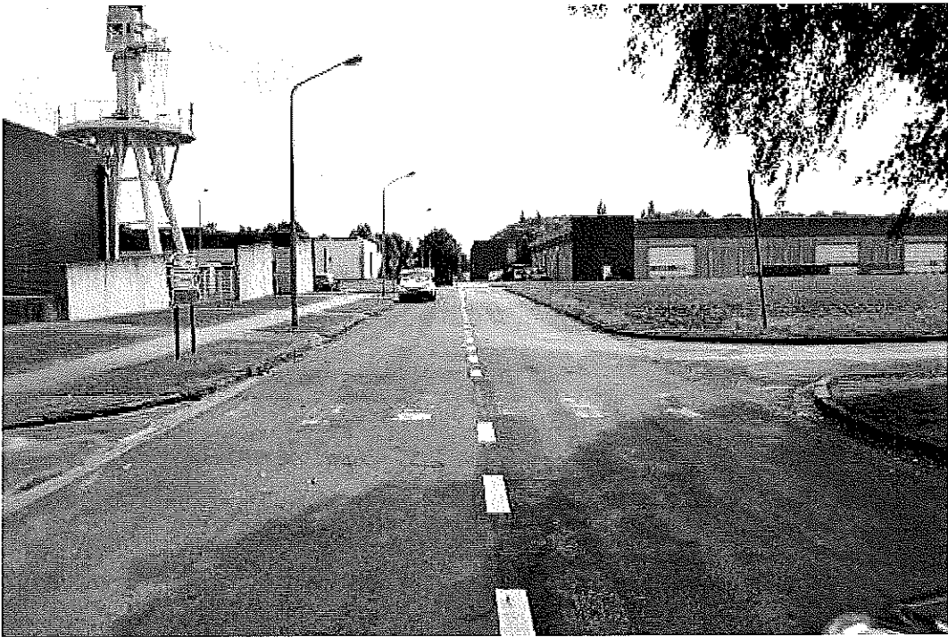
Photo 9: Route à travers du bloc 13 deviendra chemin sens unique dans la direction bloc 15 - 18
