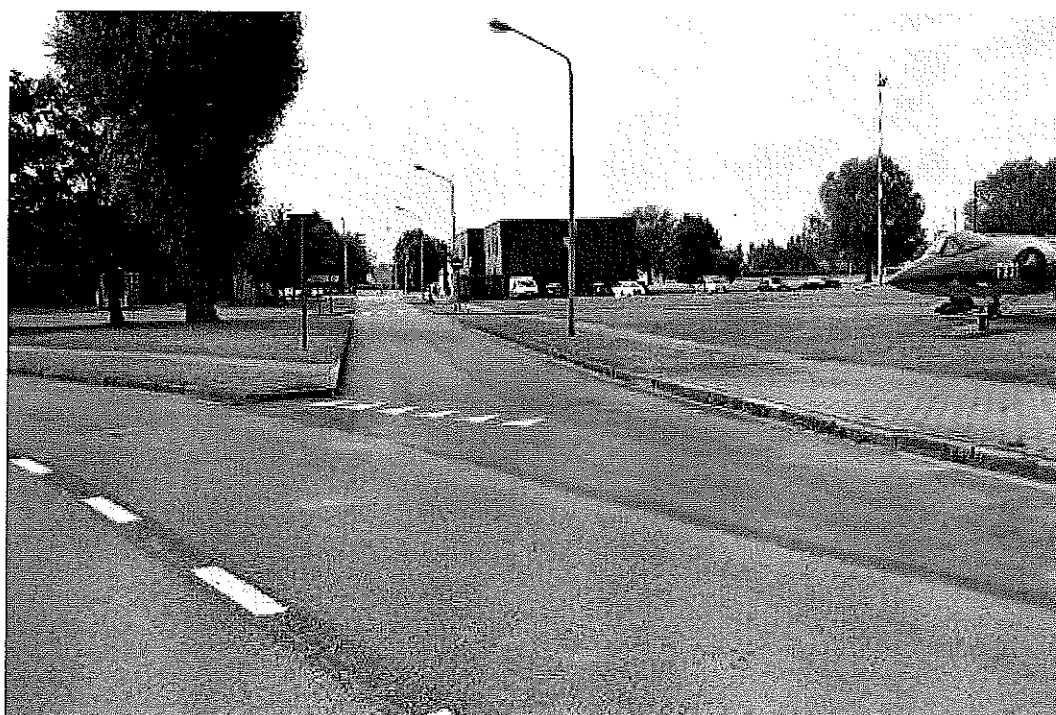
Photo 12: Logt blk 7 - 7Bis: remplacement du panneau "céder le passage" par un panneaux "d'arrêt" et pose d'un panneau "fin zone 30 Km /Hr" -(voir proposition avis motivé)
