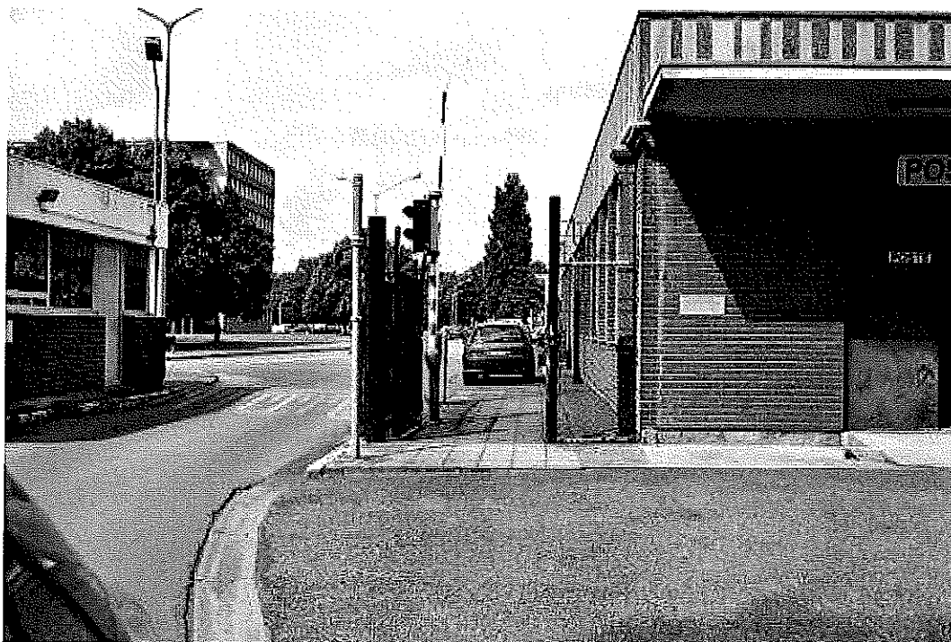
Photo 19: pose panneau de commandement "suivre direction" et panneau "zone 30" (portail côté gauche "corps de garde" sera fermé pour contraindre la circulation "sens unique")
