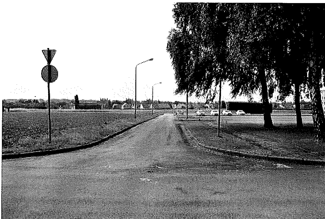
Photo 11: remplacement du panneau "céder le passage" par un panneaux "d'arrêt" et pose d'un panneau de commandement "suivre la direction à droite" "stop" (voir de la position de quittant le parking"
