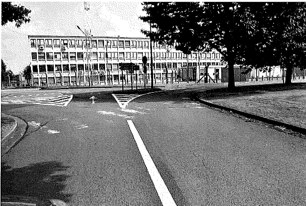
Photo 21: Amélioration (passage zébré) et modification marquage routier selon la nouvelle Sit
