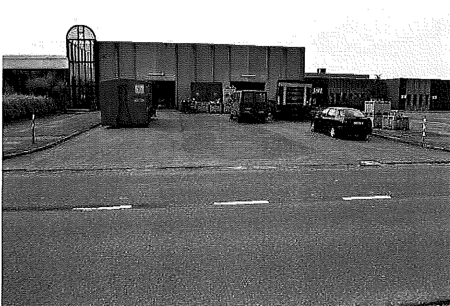
Foto 8: Plaatsen bord verboden de parkeren" (alleen nog laden/lossen door leveranciers)
