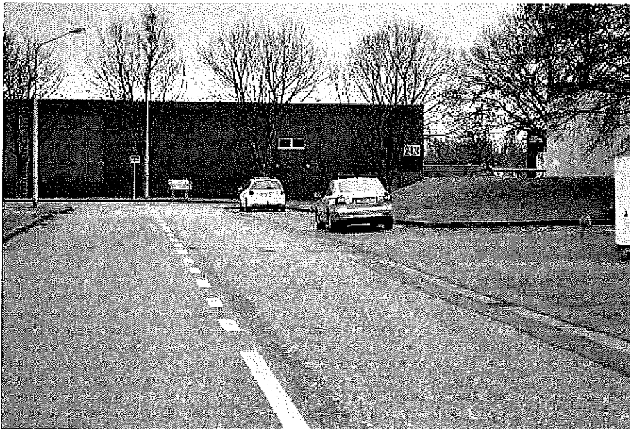
Foto 5: Gebodsbord "dubbele richting" (POL station & blok 22) wordt vervangen door gebodsbord "richting volgen naar rechts"
