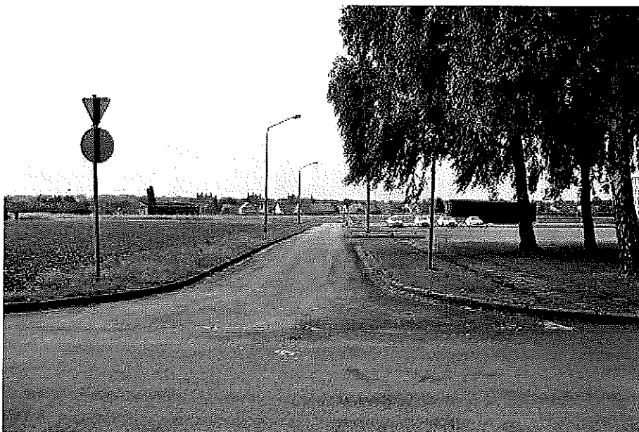
Foto 11: vervangen borden "voorrang verlenen" door "stop" bord en plaatsen gebodsbord "volgen van de rijweg van rechts (gezien vanuit de positie bij het verlaten van de parking"
