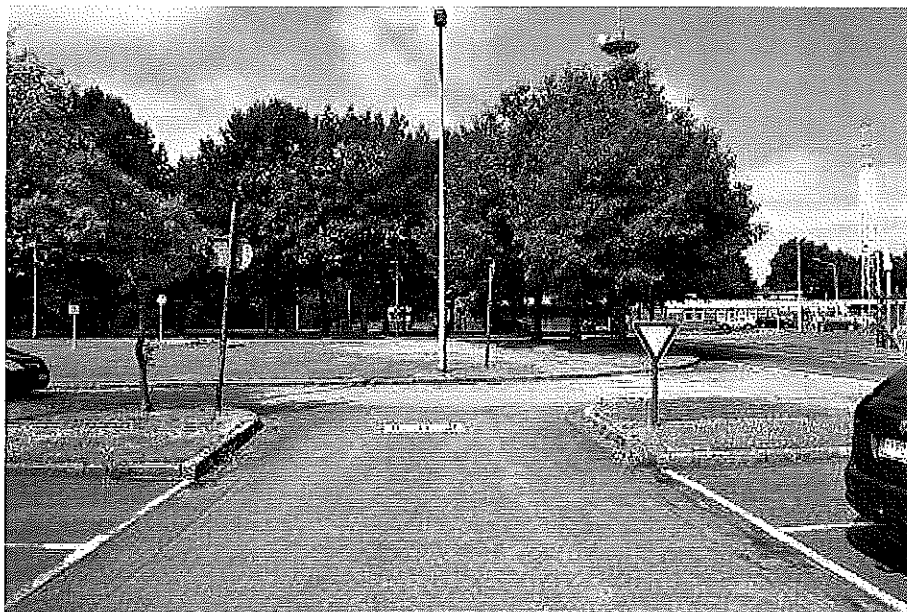
Foto 16: parking achter blok 4A: plaatsen gebodsbord "richting volgen naar rechts" en plaatsen stopbord ter hoogte van de hoofdweg
