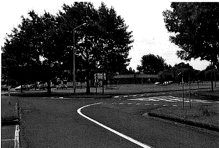
Foto 18: Uitgang parking blok 2: plaatsen verbodsbord "verboden naar rechts"
