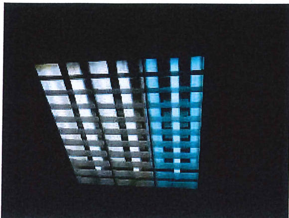
Foto 7: verschillende lampen in 1 armatuur: (kleurtemperatuur en kleurweergave-index)
