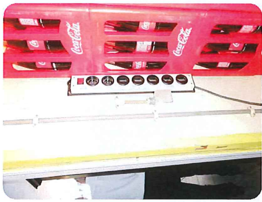
Photo 13 : multiprise dans local stock
