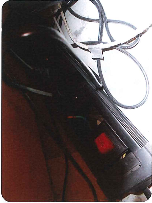
Photo 19 : bureau accueil clients (caisse)
