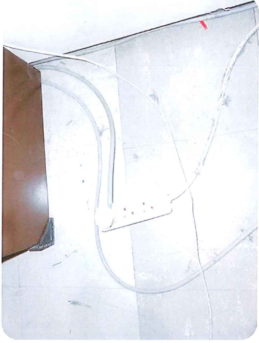
Photo 18 : bureau accueil clients (caisse)
