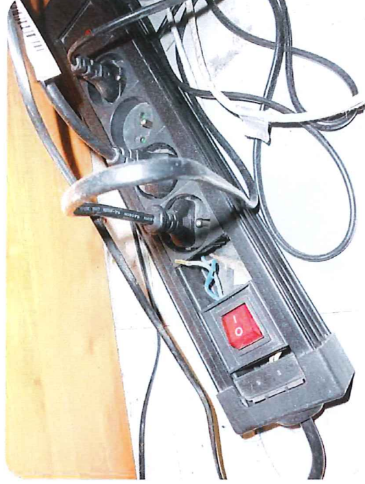
Photo 20 : bureau accueil clients (caisse)
