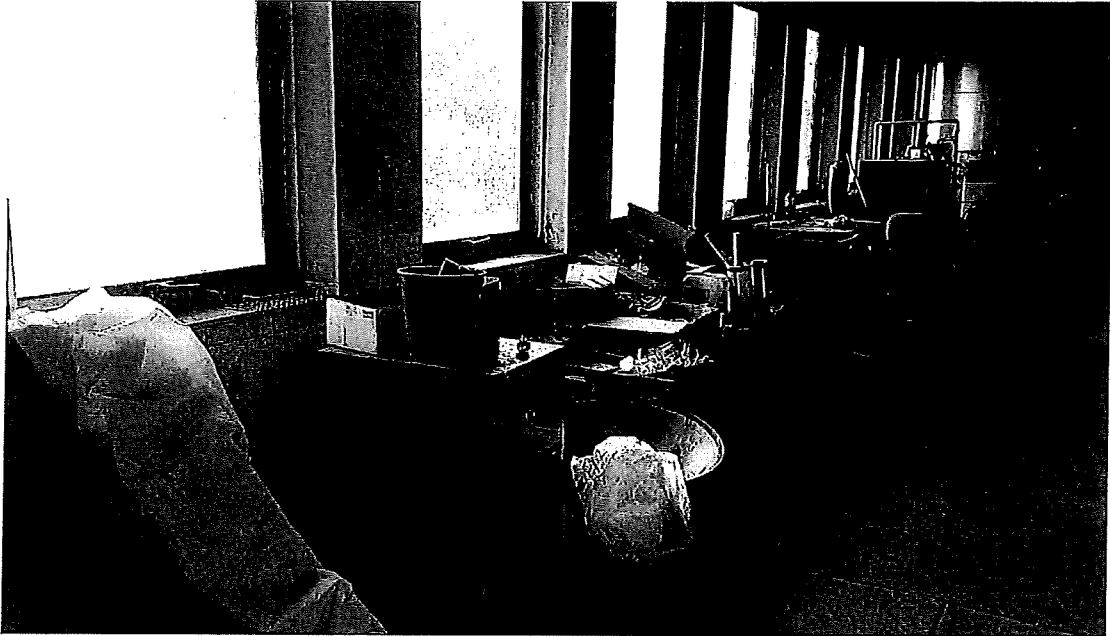
Photo 1 Matériel entreposé dans la chaufferie Bloc 4
